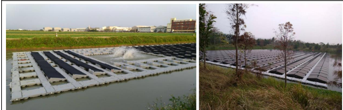
圖 4-17 功能性調節蓄水池太陽能板設置示範圖
