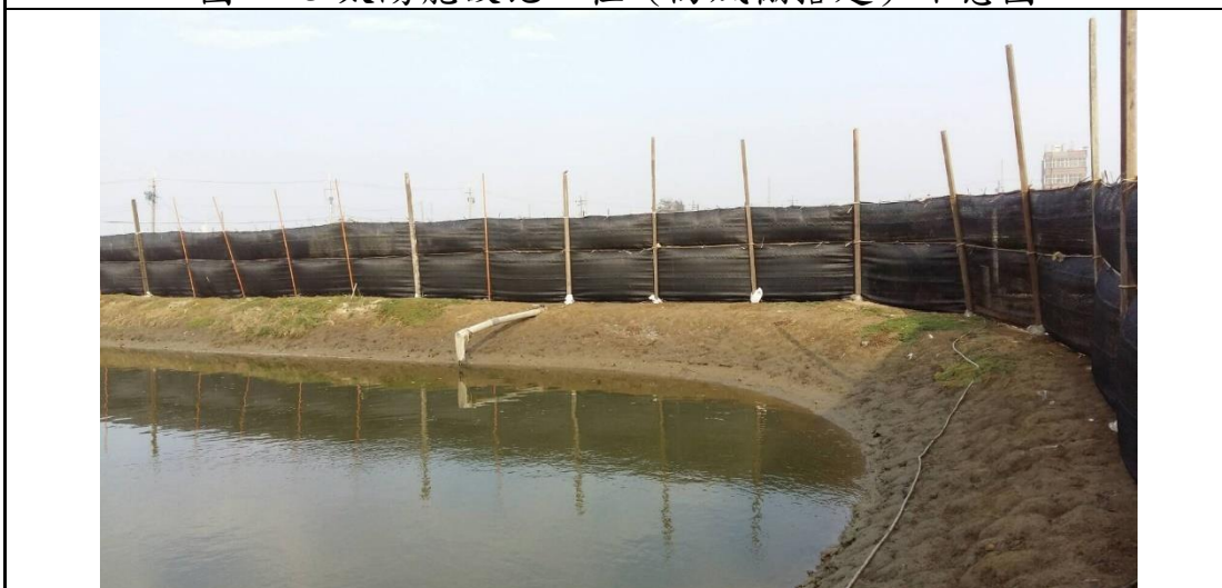
圖 4-14 養殖防風網設施架設示意圖
