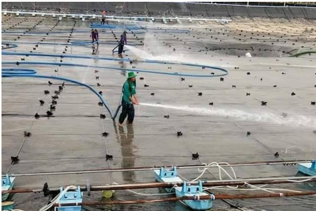
圖 4-22 HDPE 養殖池清洗示意圖
