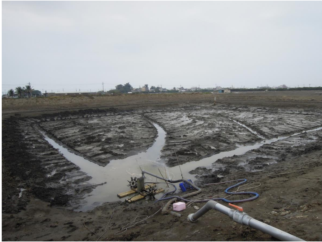
圖 4-17 養殖池曬池開溝集水示意圖
