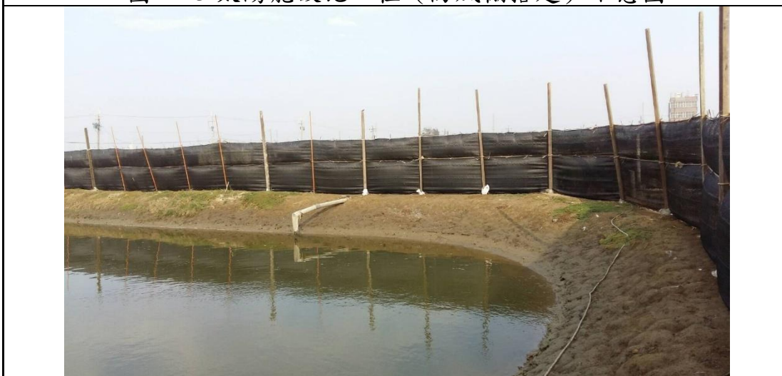
圖 4-14 養殖防風網設施架設示意圖
