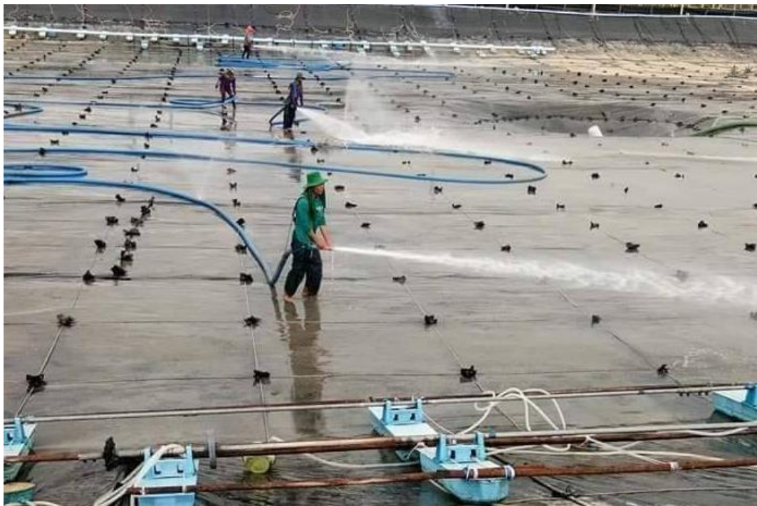
圖 4-22 HDPE 養殖池清洗示意圖
