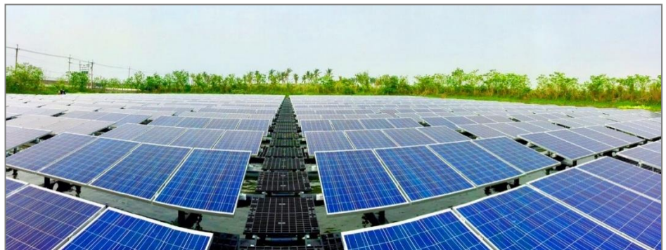
圖 4-6 水面型浮動式太陽光電發電設備示意圖（正面）
