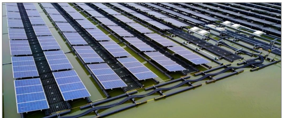
圖 4-7 水面型浮動式太陽光電發電設備示意圖（側面）
