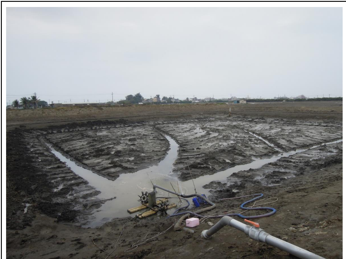
圖 4-17 養殖池曬池開溝集水示意圖
