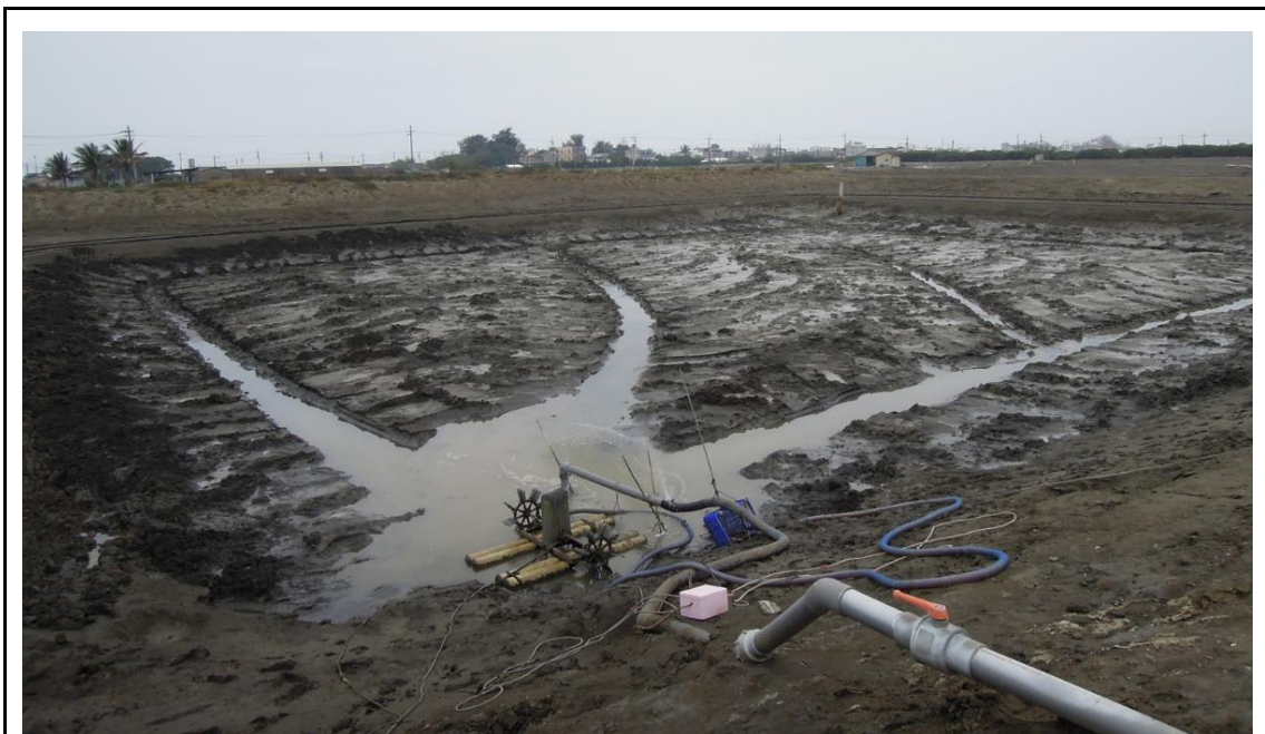
圖 4-17 養殖池曬池開溝集水示意圖
