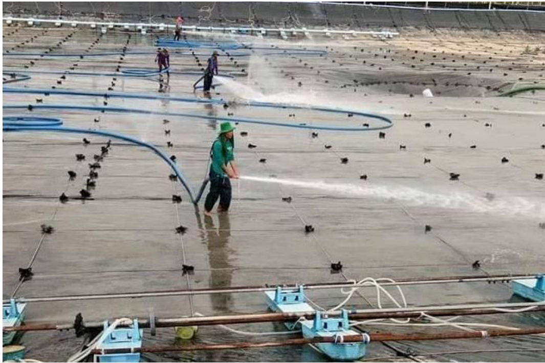
圖 4-20 HDPE 養殖池清洗示意圖
